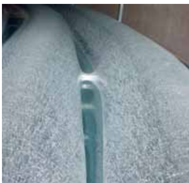
Eisbildung um den Wärmeübertrager im Eis-Energiespeicher
