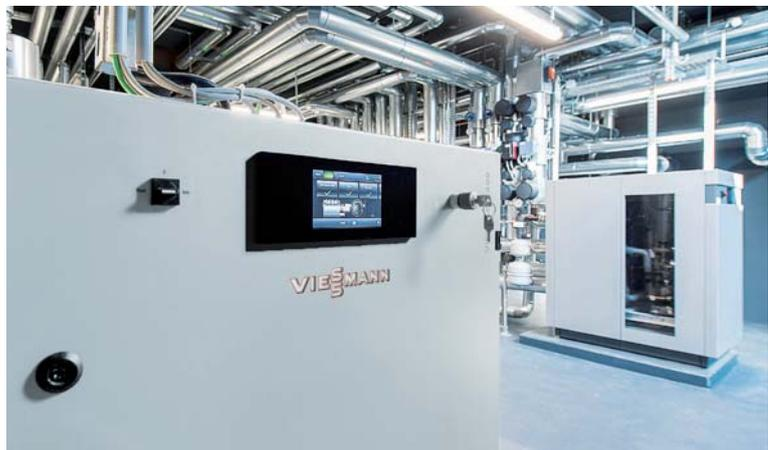
Das Blockheizkraftwerk Vitobloc 200 hat eine Leistung von 6 kW<sub>el</sub> und 15 kW<sub>th</sub>.
