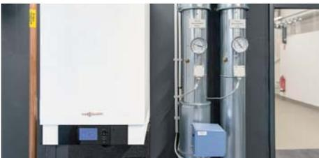
Das Vitodens 200-W Gas-Brennwertgerät deckt die Spitzenlasten ab.
