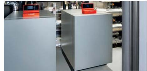
Zwei Wärmepumpen Vitocal 300-G gewinnen Wärme und Kälte aus einem Eis-Energiespeichersystem.
