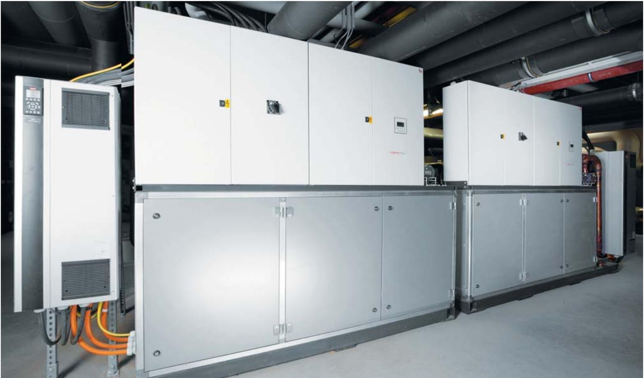
Die KWT-Wärmepumpen haben eine Leistung von 720 kW.
